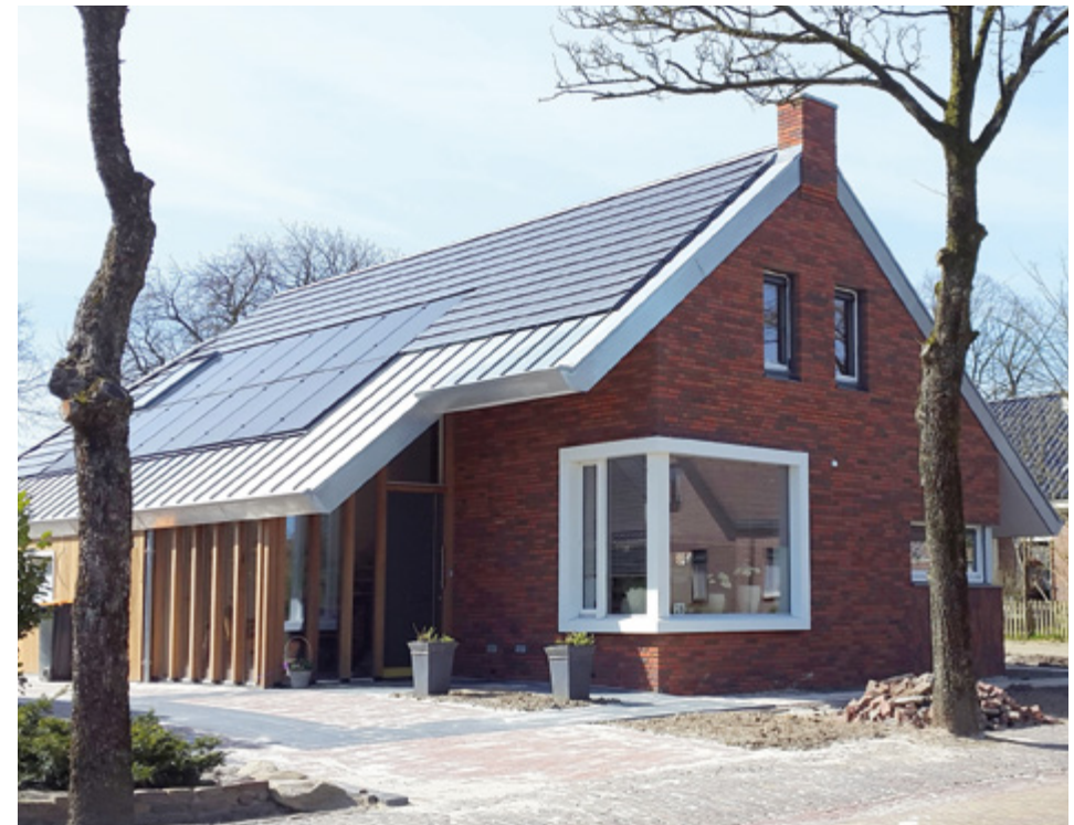
Sloop/nieuwbouw karakteristieke gebouwen. ▼
