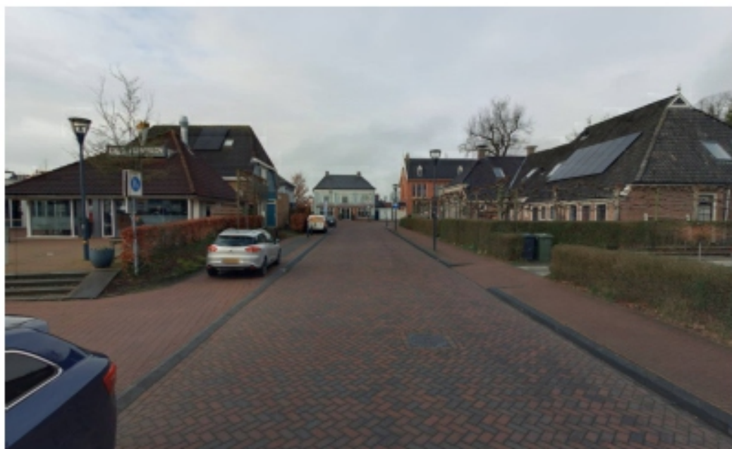
Links Overtuinen 1, rechts woonbebouwing aan de Burg. Kruisingalaan.
