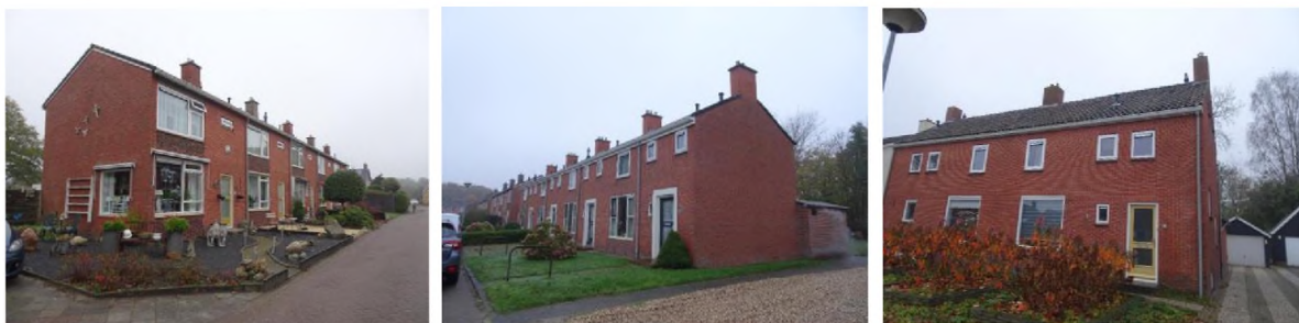
Figuur 16 Voorbeelden van de Groningse situatie bij woningen in beheer bij woningcorporatie Wold & Waard. De meeste van de onderzochte huizen staan vrij van begroeiing, waardoor steenmarters niet via beplanting richting de dakgoot kunnen klimmen. De enige mogelijkheid om op hoogte te geraken is via de regenpijpen, maar deze lopen telkens uit op een dood spoor. Er zijn namelijk geen duidelijke plekken aangetroffen waar een steenmarter via de dakgoot nog naar een zolder kan kruipen. Daarvoor is de bouwwijze en de staat van onderhoud van de buitengevels van de onderzochte woningen niet slecht genoeg.
