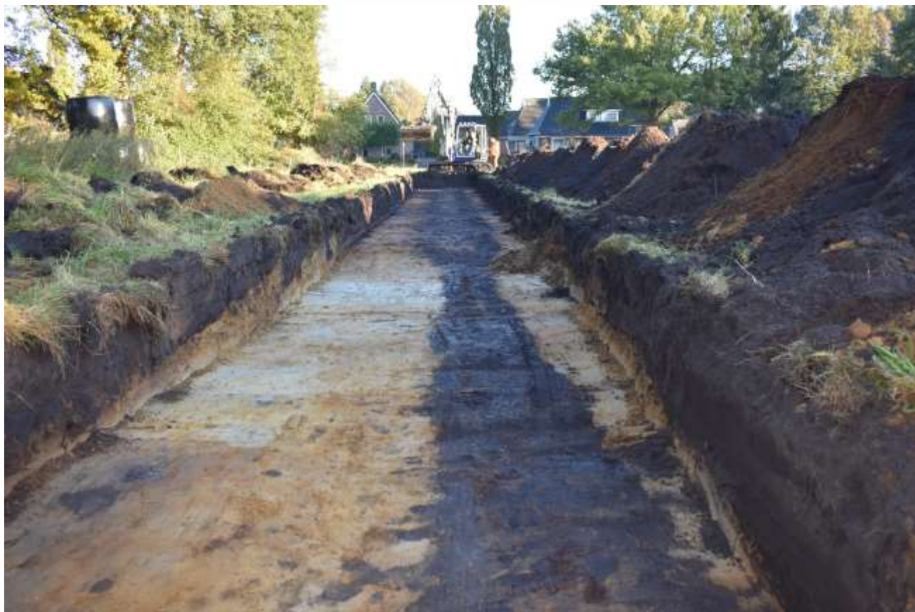
Figuur 4: Foto plangebied tijdens de werkzaamheden (genomen op 28 oktober 2021)
