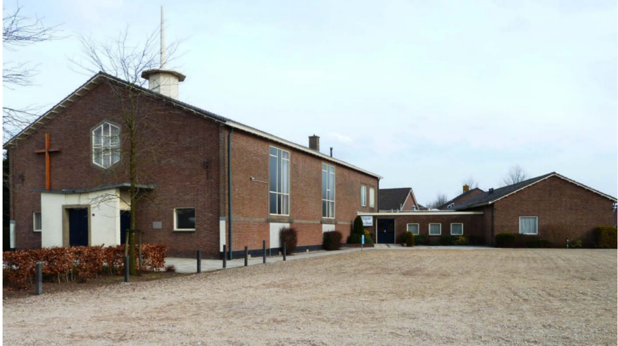
Figuur 2.1 Voormalige bebouwing op de locatie (Bron: SD Projecten).
