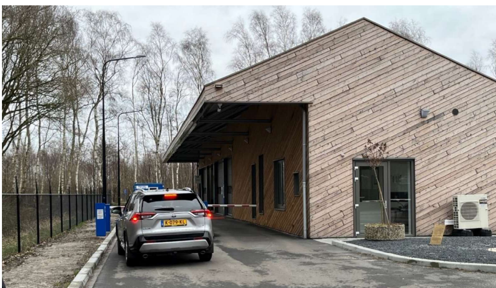
Afbeelding 5: Houten aankleding van de innamestraat in Roden, gemeente Noordenveld. Deze innamestraat is een bijgebouw (niet geïntegreerd in het bordes).
